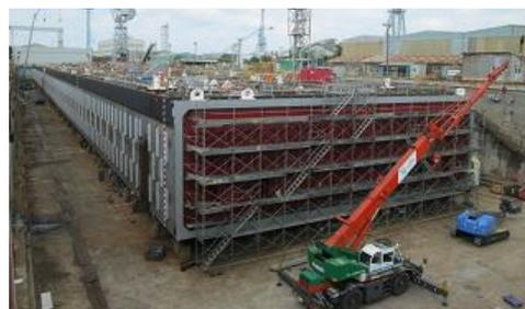
製作ドック内の沈埋函の鋼殻
